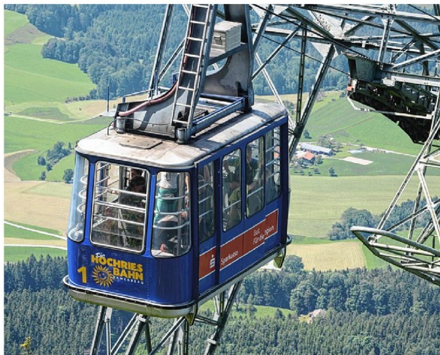
Vor allem die Steuerungstechnik der Hochries-Seilbahn muss erneuert werden. Das fordert der TÜV. Sonst droht der Entzug der Betriebserlaubnis.
